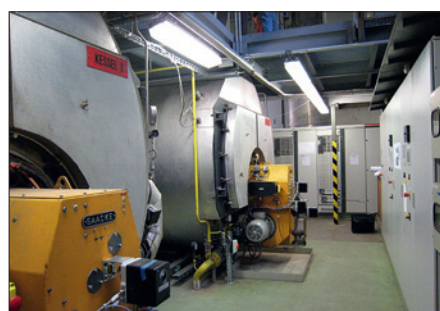
Neues Speichermanagement steuert die Brennerleistung.
