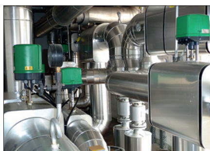
Installationen/Verrohrungen für die Heizkesselanschlüsse.
