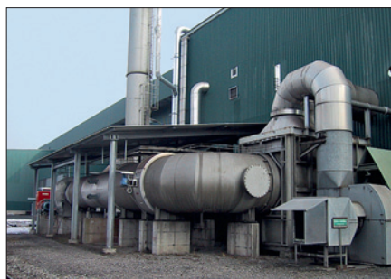
Abhitze-kessel mit sehr unregelmässiger Wärmeproduktion.
