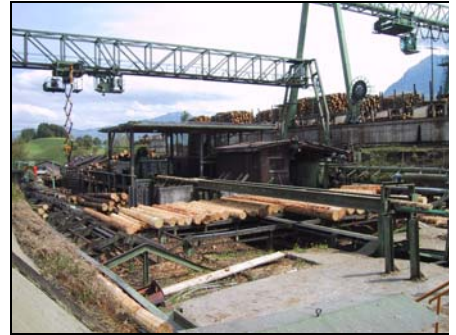
Energierückgewinnung beim Absenken von Lasten.
